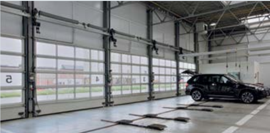
维修车间 大面积的铝框视窗可以大大增加室内亮度和通透性。
