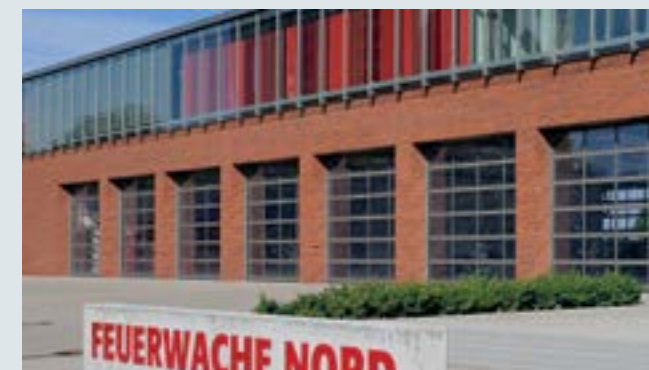
消防中心 大视窗为建筑物内提供了更清晰的视野和光照
